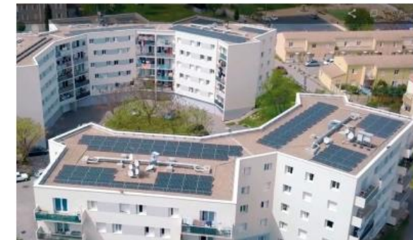
Installations en toiture
